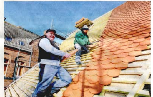
Ingo Voss und Jens Hanig von der Firma G & V Dacheindeckung Zörbig.
