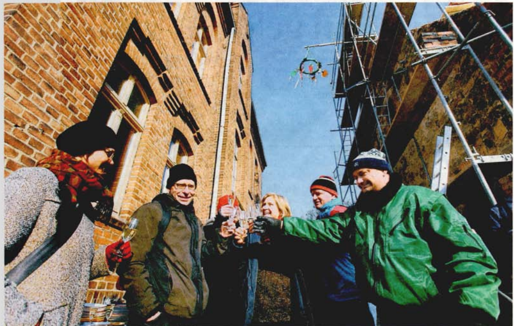
Gemeinsam wurde beim gestrigen Richtfest auf das weitere Gelingen beim Ausbau der ehemaligen Pfarrscheune von Quetz angestoßen. FOTOS: THOMAS RUTKE
